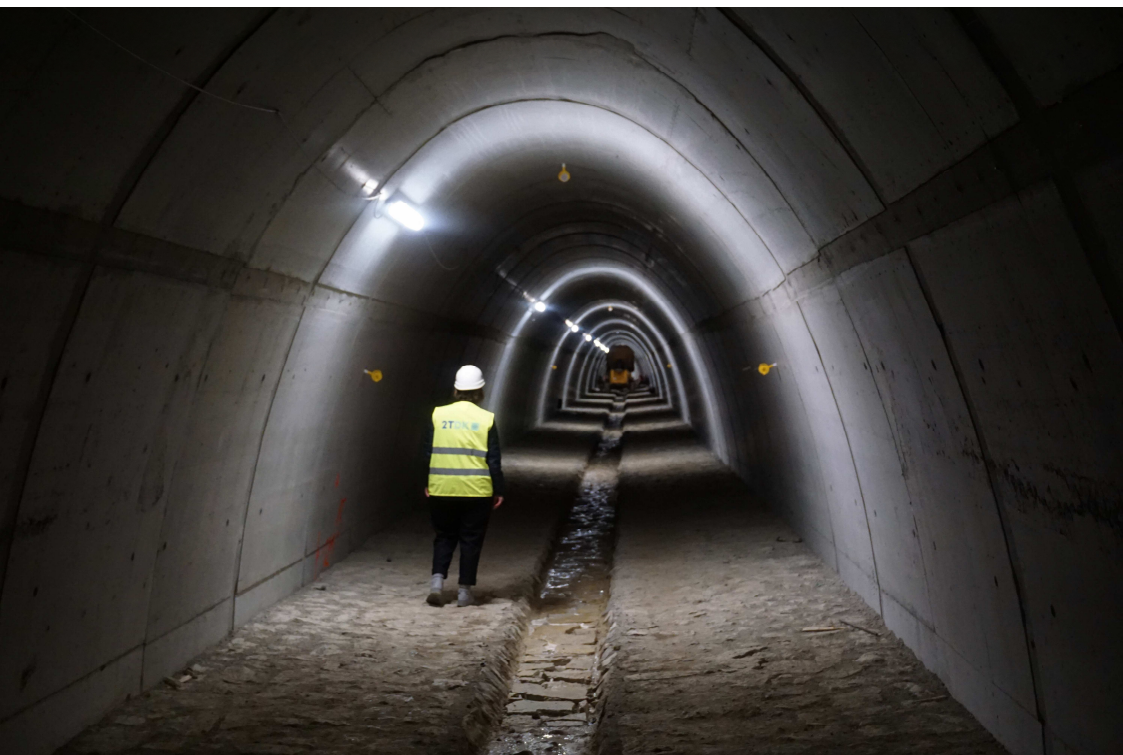
ZAKLJUČENA IZVEDBA PREPUSTA
